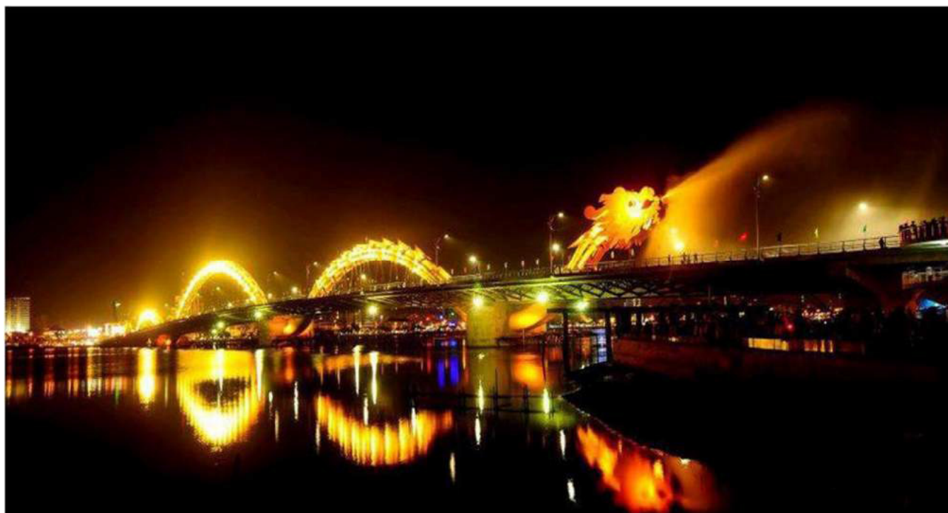
Ứng dụng trong phần kết cấu Cầu Rồng- Đà Nẵng
