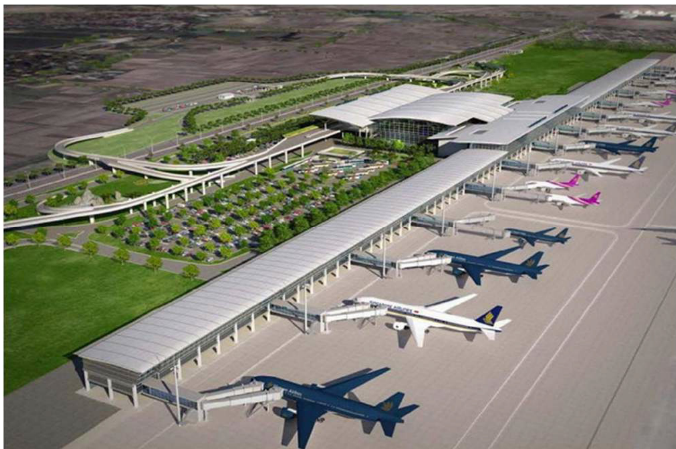
Ứng dụng trong phần kết cấu Sân bay Nội Bài
